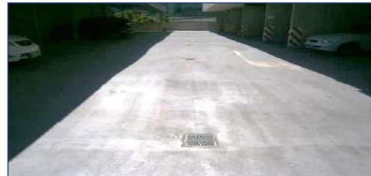
Rampa acceso al 2do nivel.
