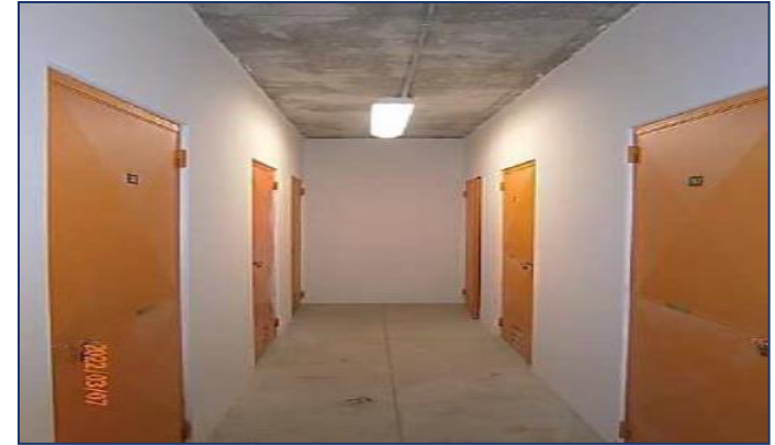
Vista de pasillos a bodegas en sótano.
