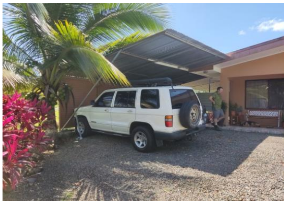
7. Vista de área de garage sin piso y corredor entrada casa
