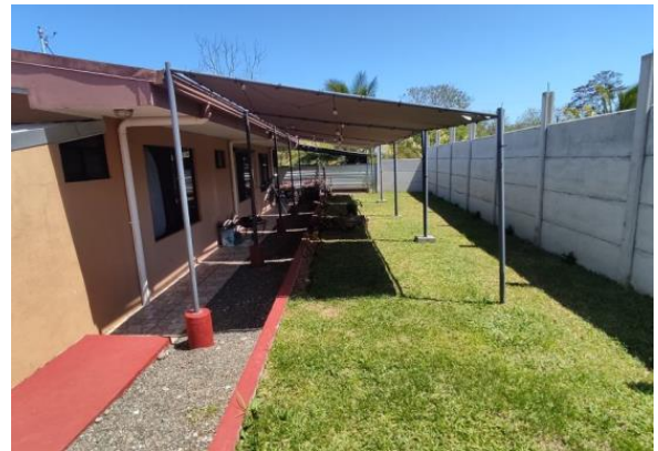
20. Vista costado Este de la casa y tapia prefa
