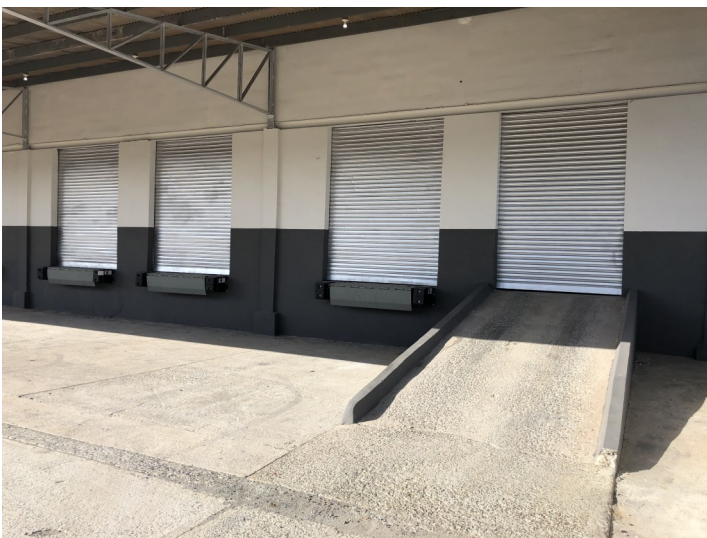
Rampa para acceso de montacargas.
