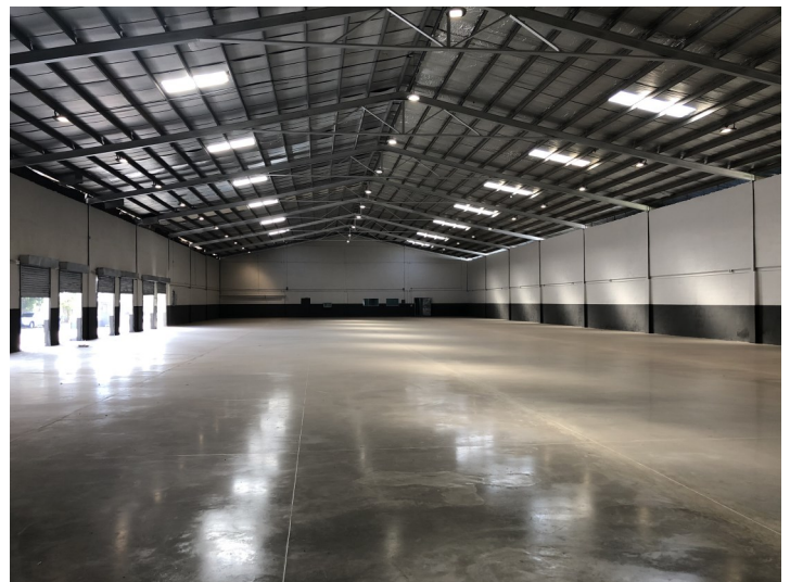
Piso industrial Pulido de 4,000 psi
