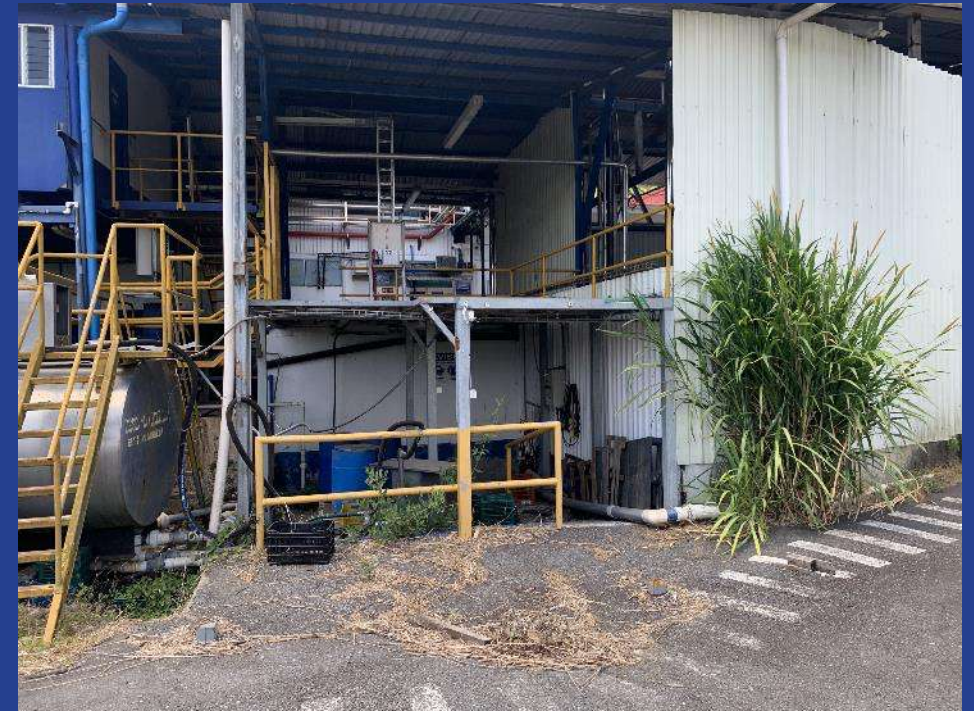
Fotografía 40. Zona mezanine (AO) y oficina PTAR (AQ).
