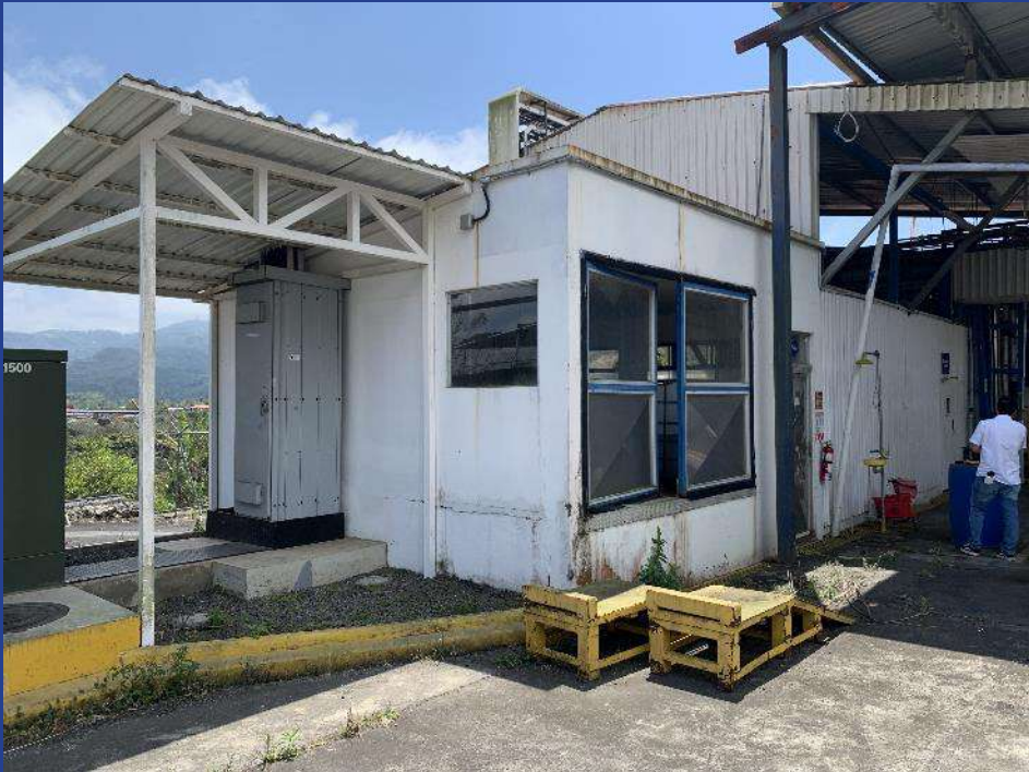
Fotografía 33. Bodega de químicos temporal (AM).
