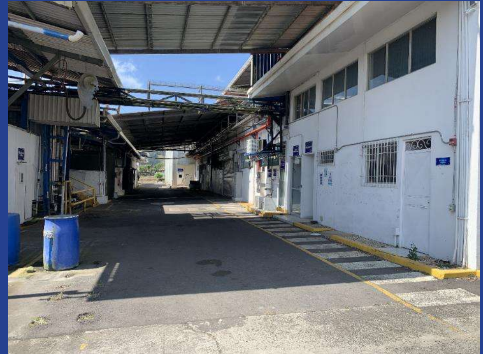
Fotografía 2. Antigua bodega a la derecha, al fondo bodega nueva a la izquierda construcciones diversas.
