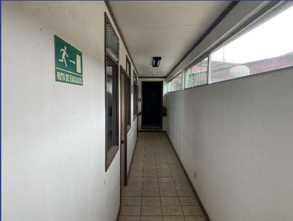
Fotografía 61. Sector pasillo y oficinas segundo nivel (BX y BC).
