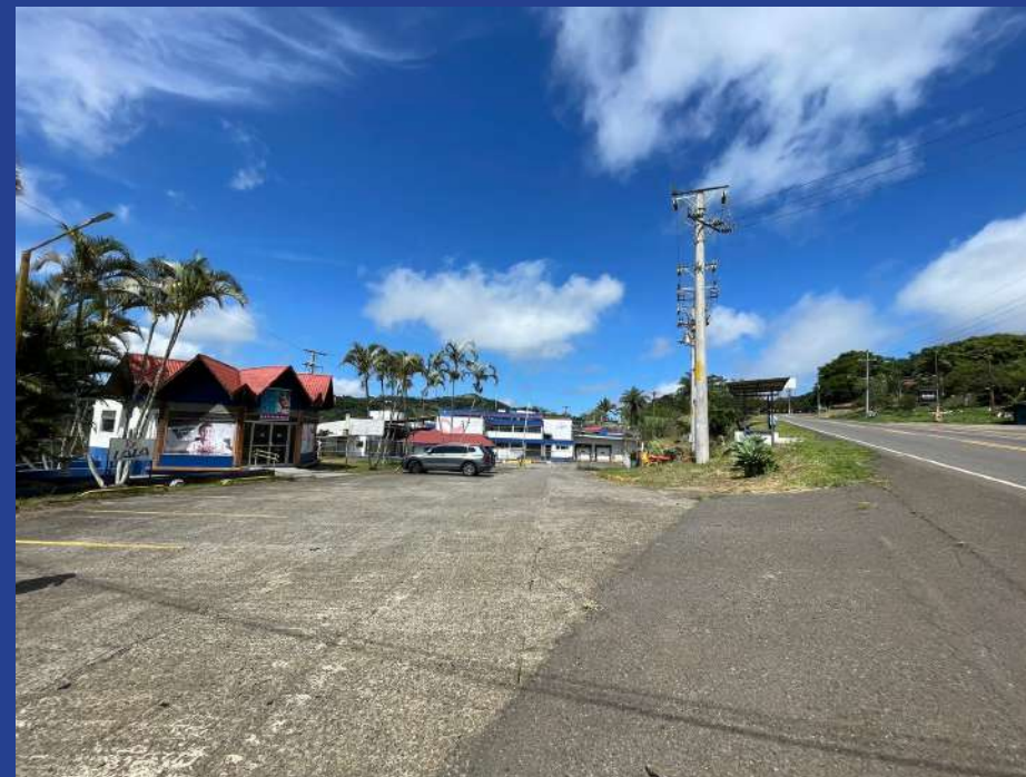
Fotografía 4. Vista frontal, incluye zona de tienda y accesos.
