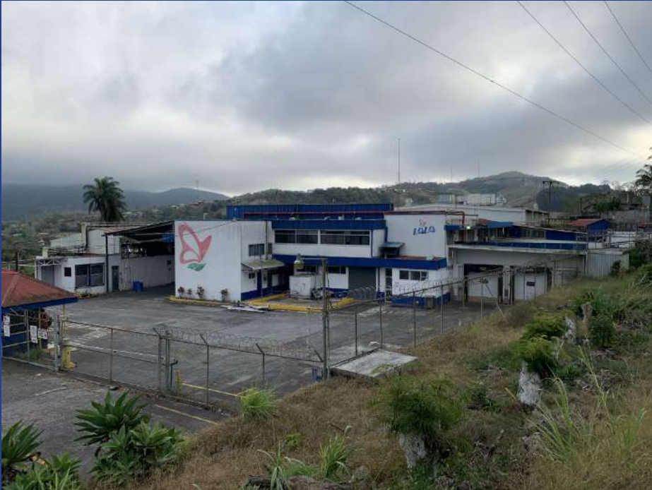
Fotografía 1. Fachada principal de Planta de Producción
