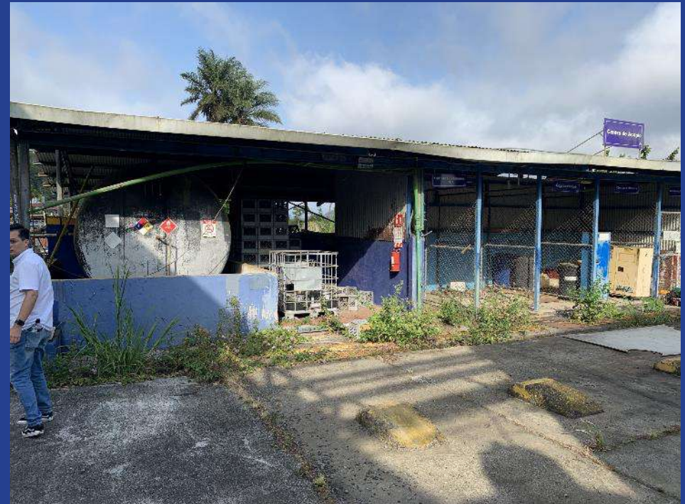
Fotografía 52. Centro de acopio y tanque bunker (BW).
