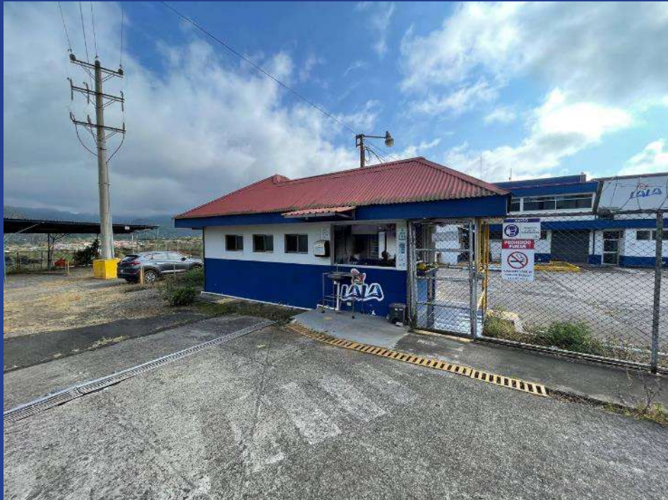
Fotografía 69. Zona caseta de guarda (BY).
