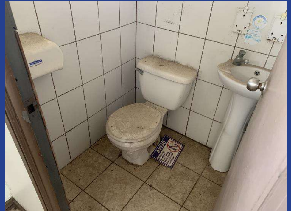
Fotografía 62. Servicios sanitario sector oficinas segundo nivel (BF).
