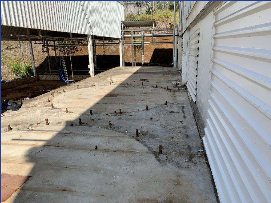
Fotografía 7. Base de Silos (B).
