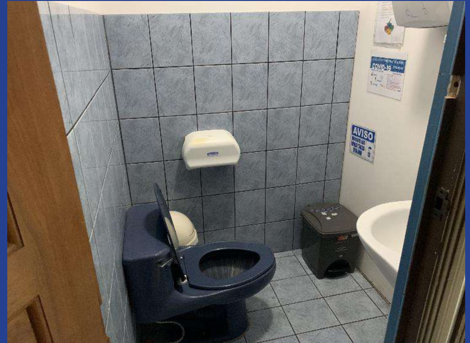
Fotografía 58. Servicios sanitario (BE).
