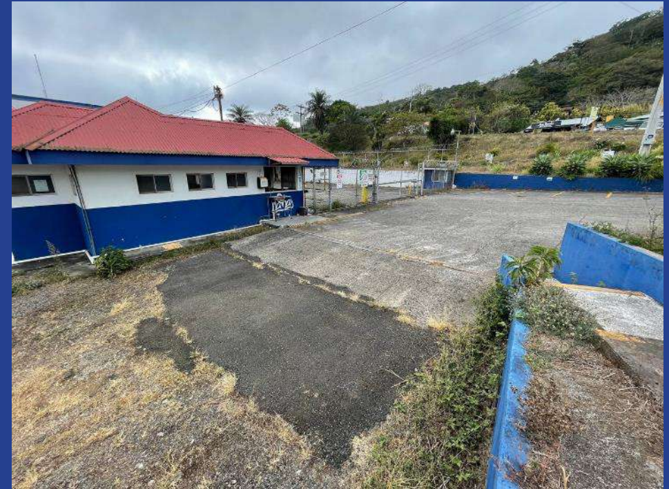
Fotografía 72. Zona caseta de guarda y parqueos.
