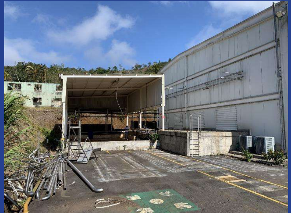
Fotografía 6. Bodega CIP (A). A la derecha parte posterior de bodega Nueva.
