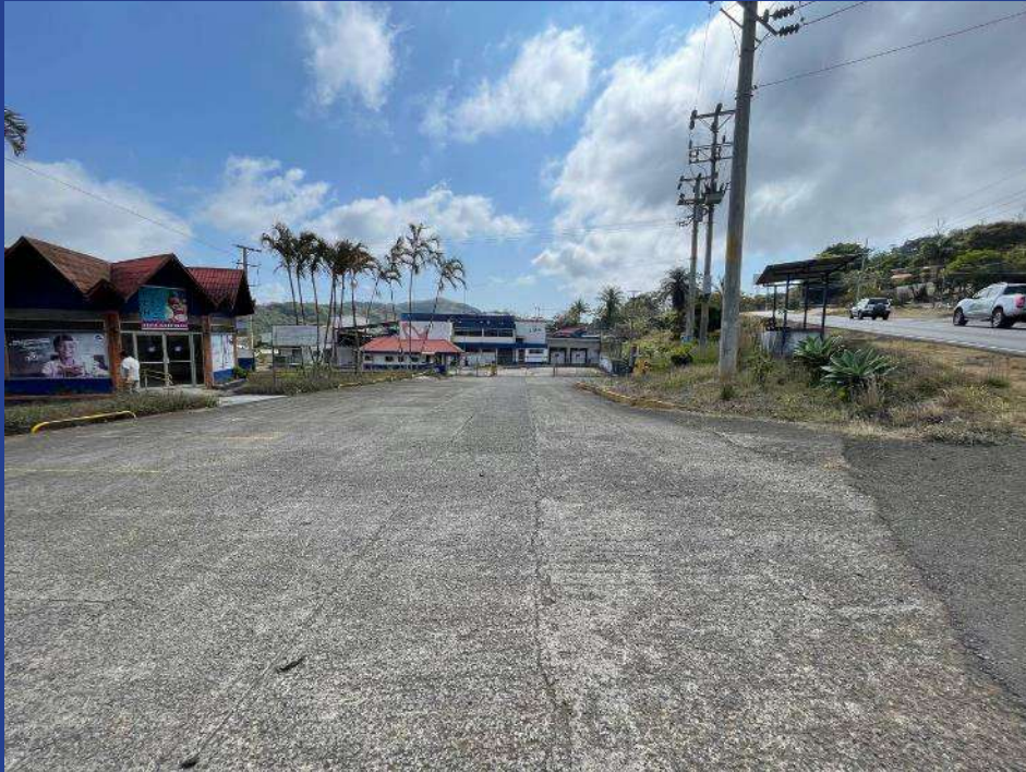
Fotografía 73. Acceso a planta. A la derecha carretera interamericana.
