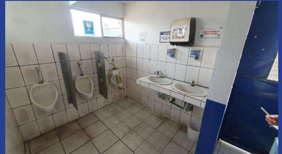
Fotografía 74. Sección Servicios Sanitarios zona caseta de guarda.
