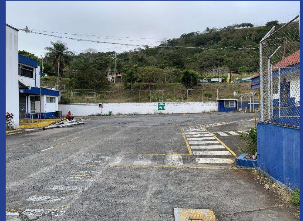
Fotografía 80. Patio de maniobras.
