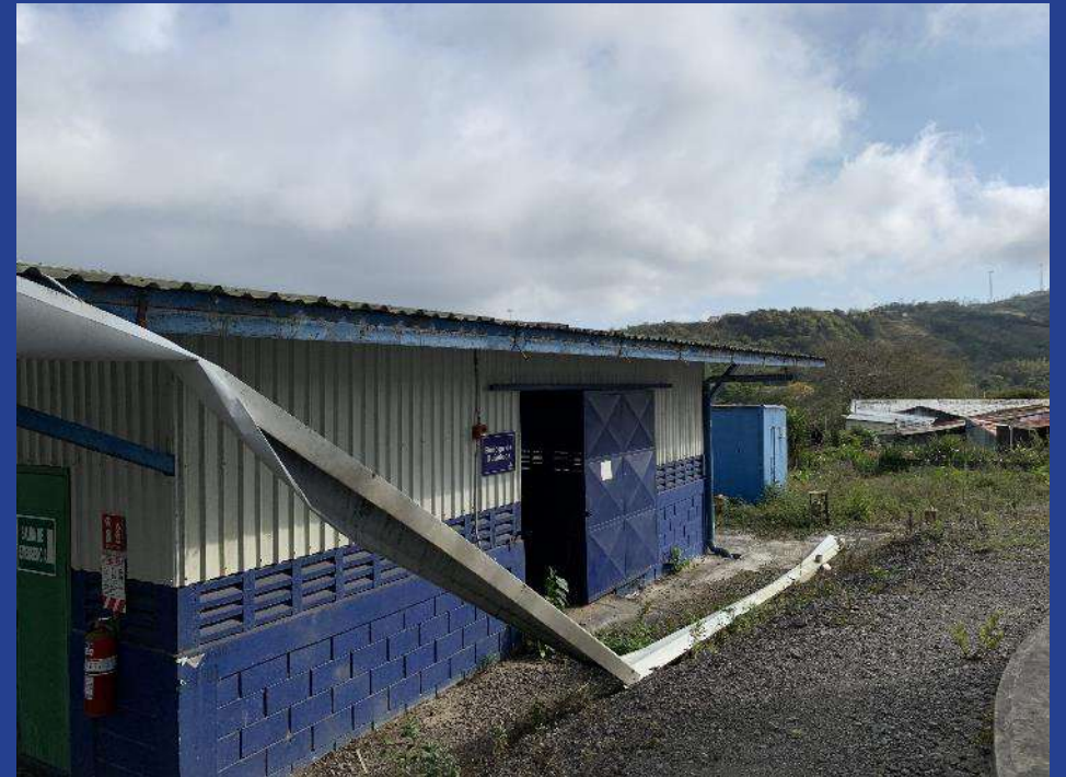
Fotografía 48. Bodega de Químicos (BU).
