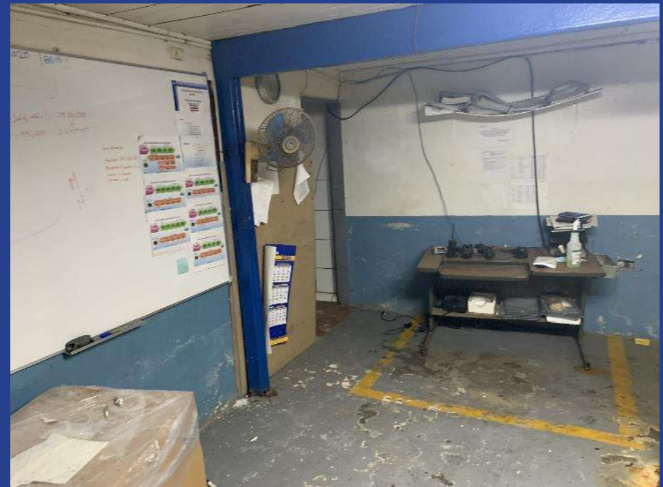
Fotografía 42. Bodega de repuestos primer nivel (AX).
