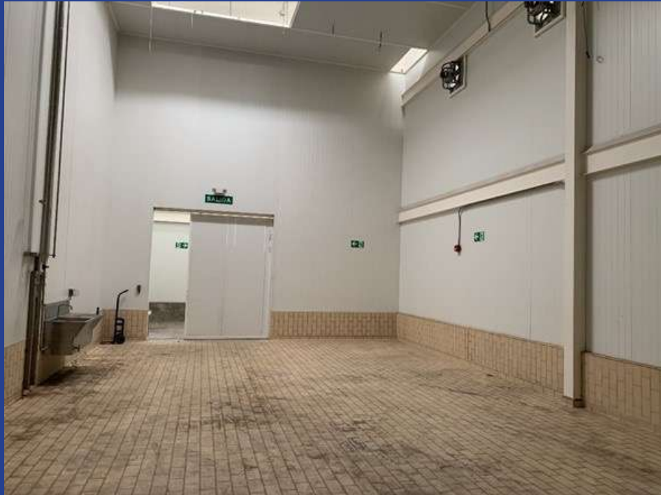
Fotografía 13. Zona Mezclas (H).
