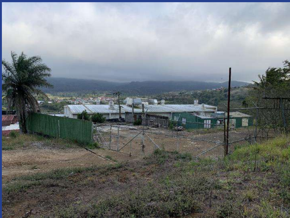
Fotografía 3. Vista lateral de la planta de producción.
