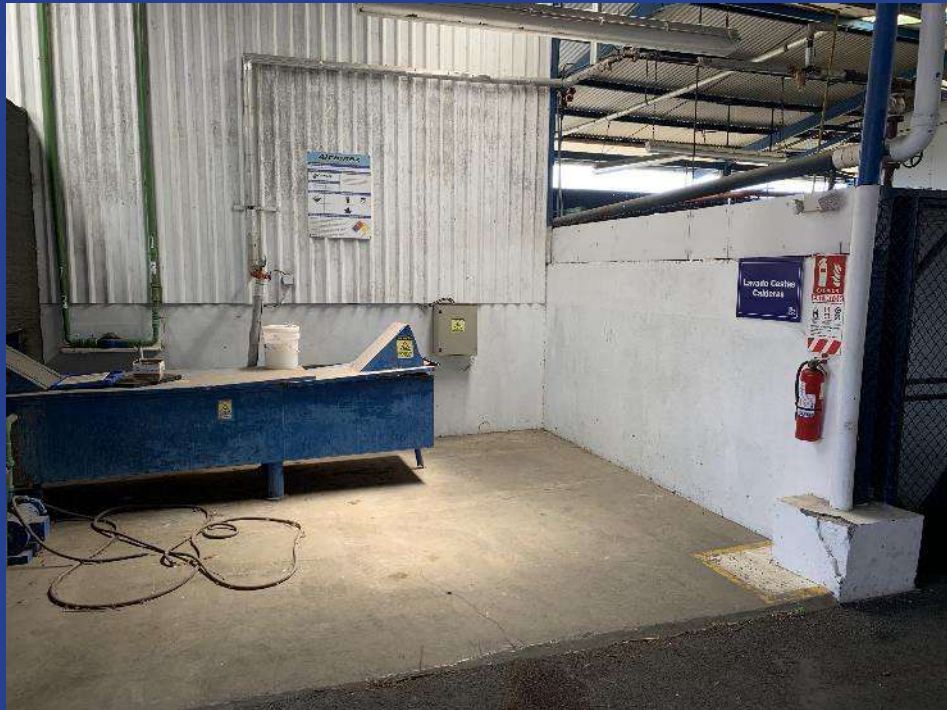
Fotografía 37. Zona lavado cestas calderas (AR).
