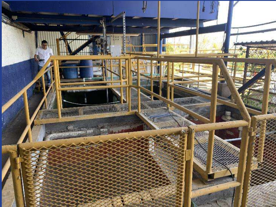
Fotografía 39. Zona PTAR (AS).
