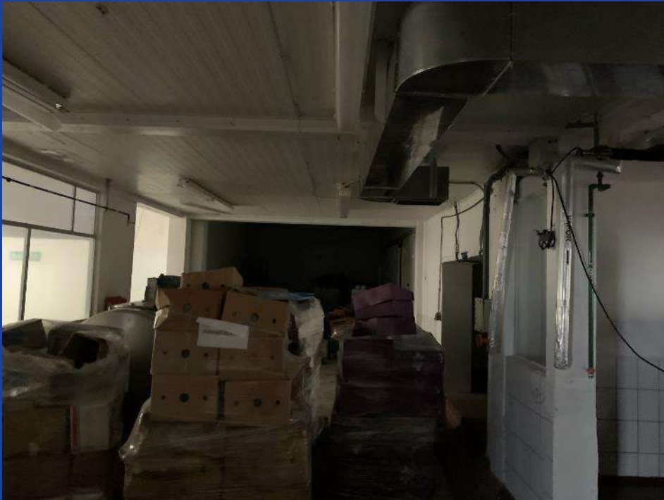
Fotografía 19 Zona tránsito (M) y al final área ingreso cámaras refrigeración (T).
