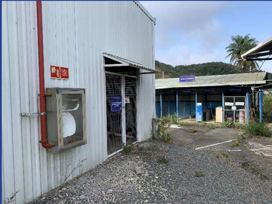
Fotografía 47. Cuarto de máquinas (BT).
