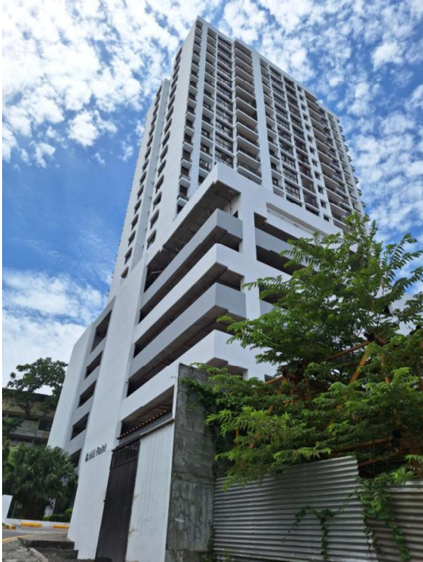
Panorámica del Edificio “PH Hill Point”.
