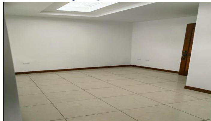
Vista de sala segunda planta
