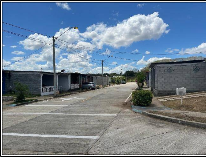
Calle de Acceso
