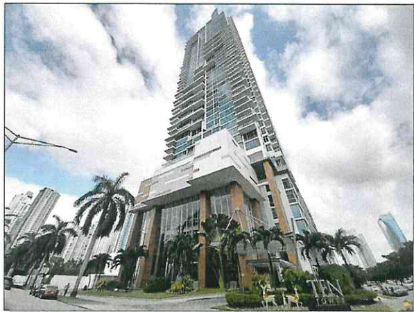
VISTA GENERAL DEL EDIFICIO PH TEN TOWER
