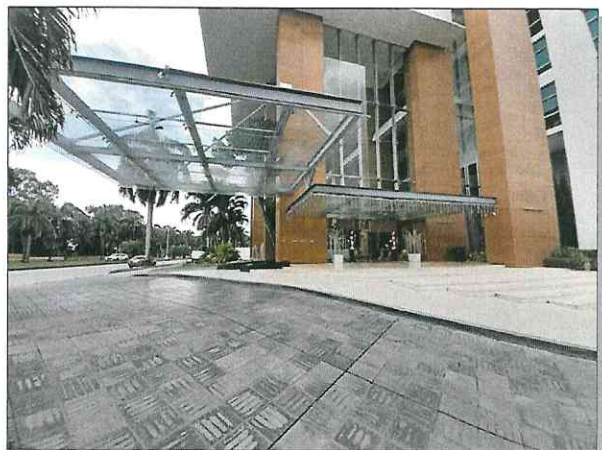
PORTA COCHERA Y ENTRADA AL EDIFICIO
