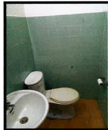
VISTA GENERAL DEL SERVICIO SANITARIO
