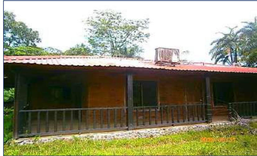
Vista exterior casa habitación
