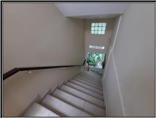
20. Escalera Hacia el Nivel Bajo.
