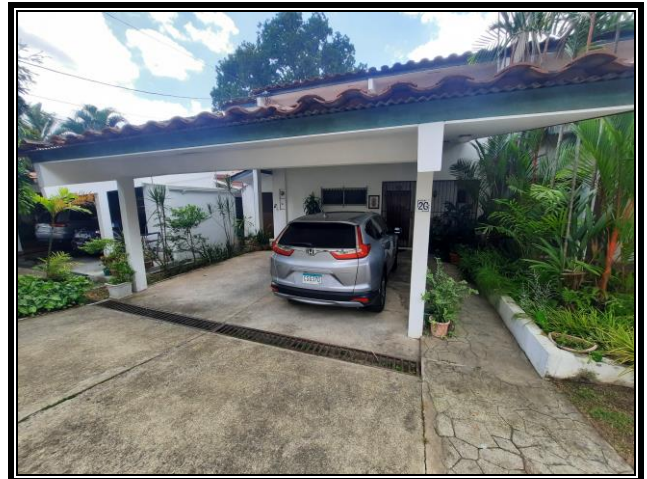
5. Estacionamiento y Vereda de Acceso.
