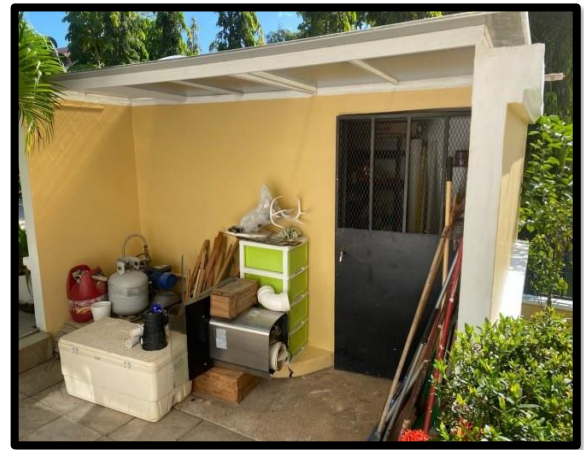
VISTA DEL CUARTO MAQUINA
