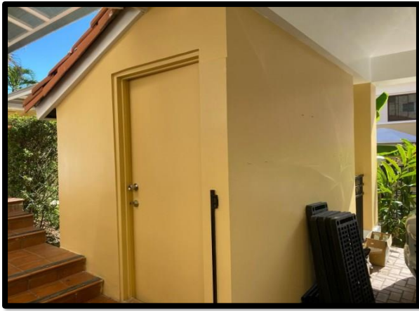
VISTA DEL DEPOSITO
