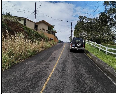
02 Calle Principal hacia el este
