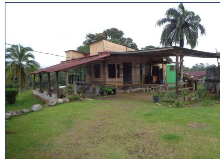
Vista casa de madera
