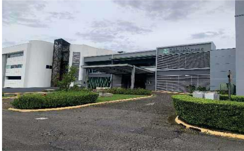
Vista acceso al Centro corporativo.
