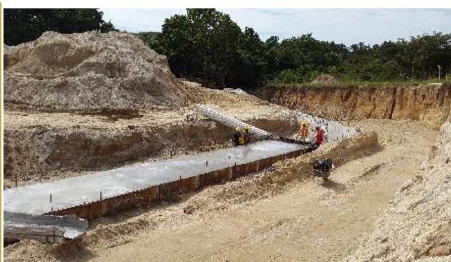
Muros de retención de concreto y movimiento de tierra
