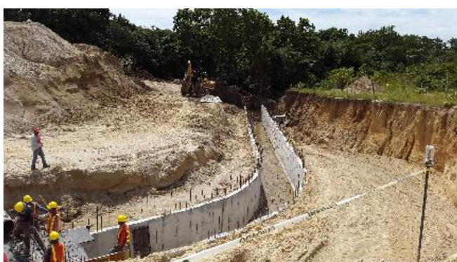
Obras de canalización pluvial ejecutadas
