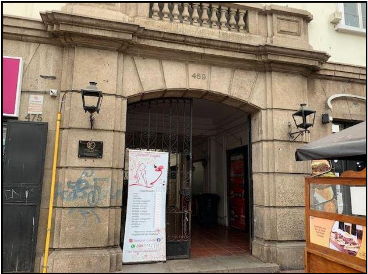
Acceso a galería.
