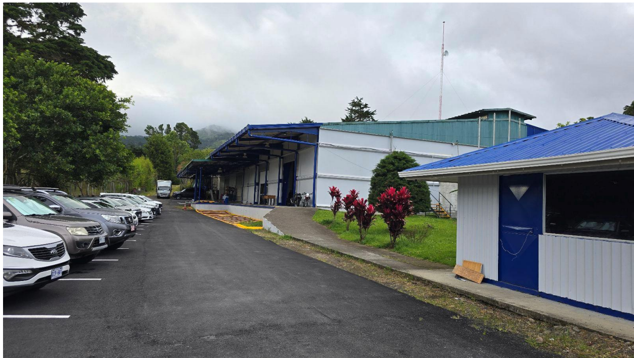
Fotografías 9, 10 y 11 – Área frontal y de acceso común con la otra bodega
