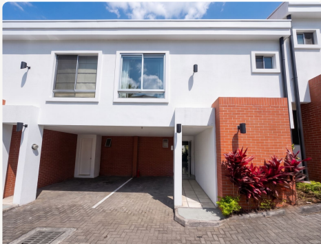
Fachada y cochera
