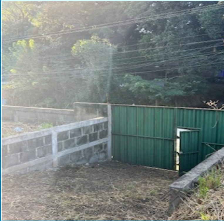
VISTA INTERNA RAMPA DE ACCESO
