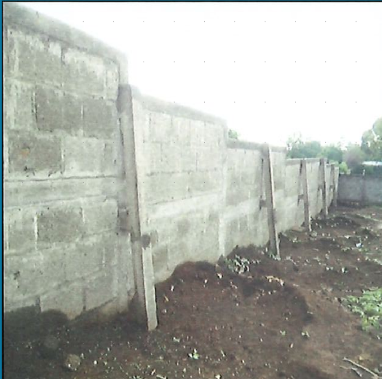
MURO LINDERO COSTADO NORTE
