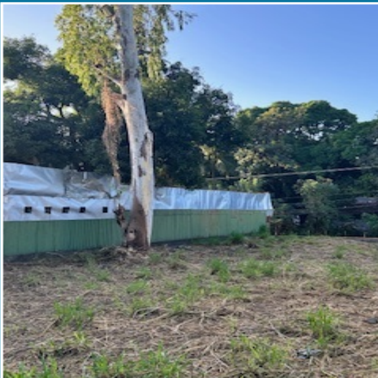
MURO LINDERO COSTADO ESTE
