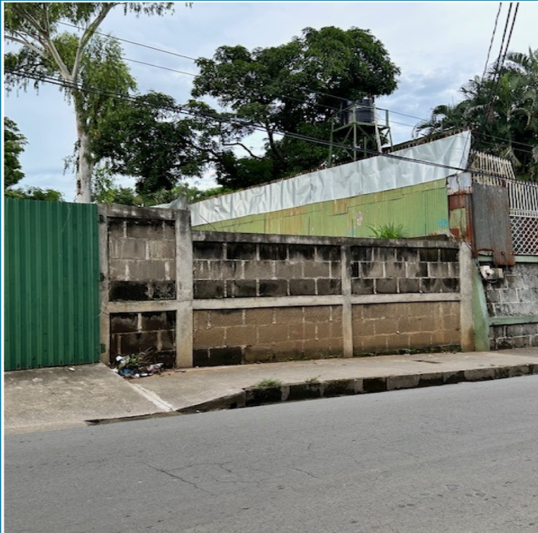
MURO FRONTAL DE PIEDRA CANTERA (Refuerzo y fundaciones diseñado y construido por Ing. Structural)
