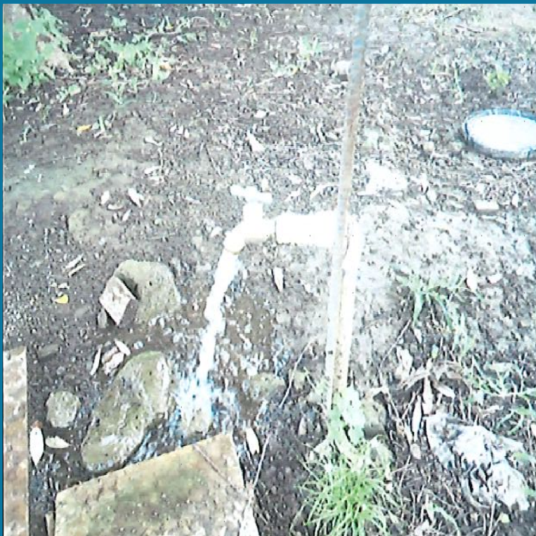
SERVICIO DE AGUA POTABLE
