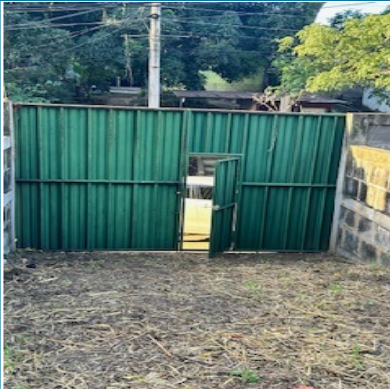
VISTA INTERNA DE PORTON Y RAMPA DE ACCESO
