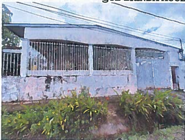
VISTA GENERAL DE LA VIVIENDA No.07
