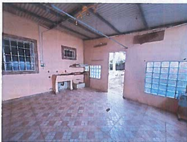
VISTA GENERAL DEL CUARTO DE LA LAVANDERÍA
