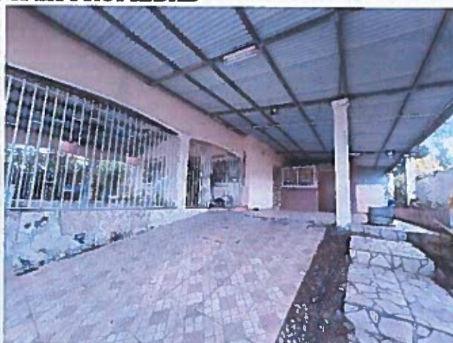
VISTA GENERAL DEL ESTACIONAMIENTO
