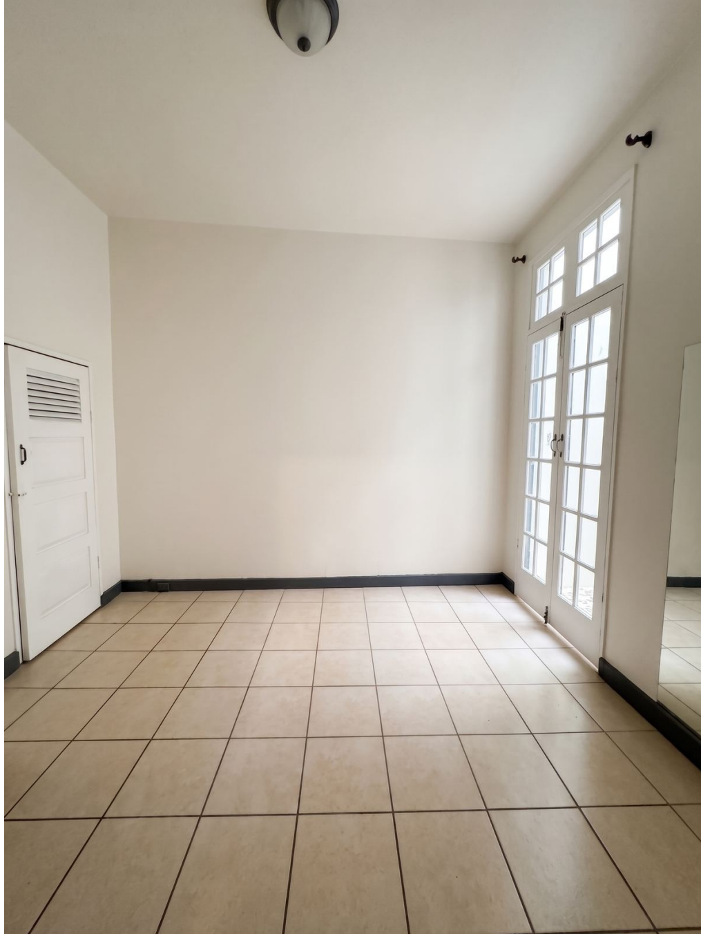
Habitacion con puertas francesas hacia el patio
