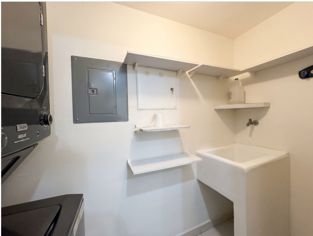
Área de lavado - detalle
