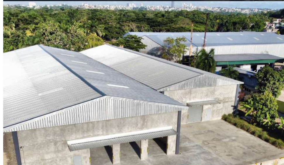
Frentes de muelles y andenes en concreto hacia el patio.
