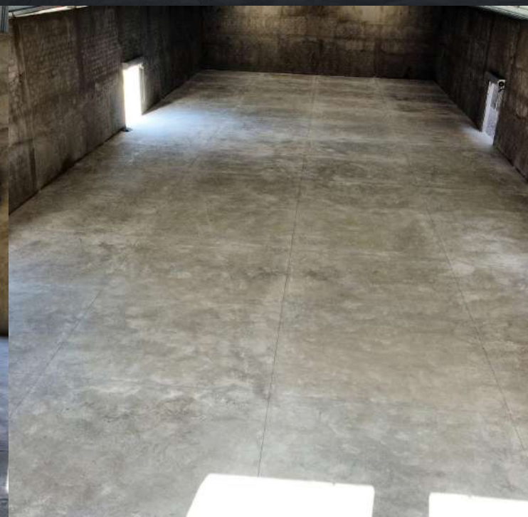
Altura libre de 6 m bajo la cumbrera.
