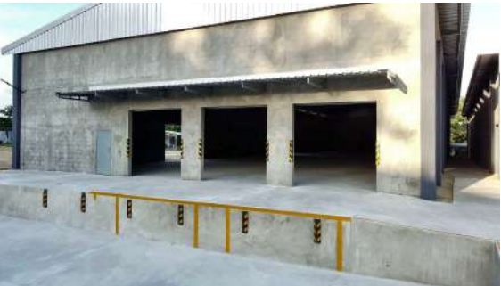
Andén de muelle en concreto y señalización de columna.
