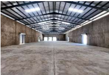
Nave diáfana de 20 m.
