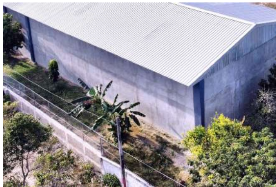
Nave 2 · lado largo de 55 m, vista aérea.
