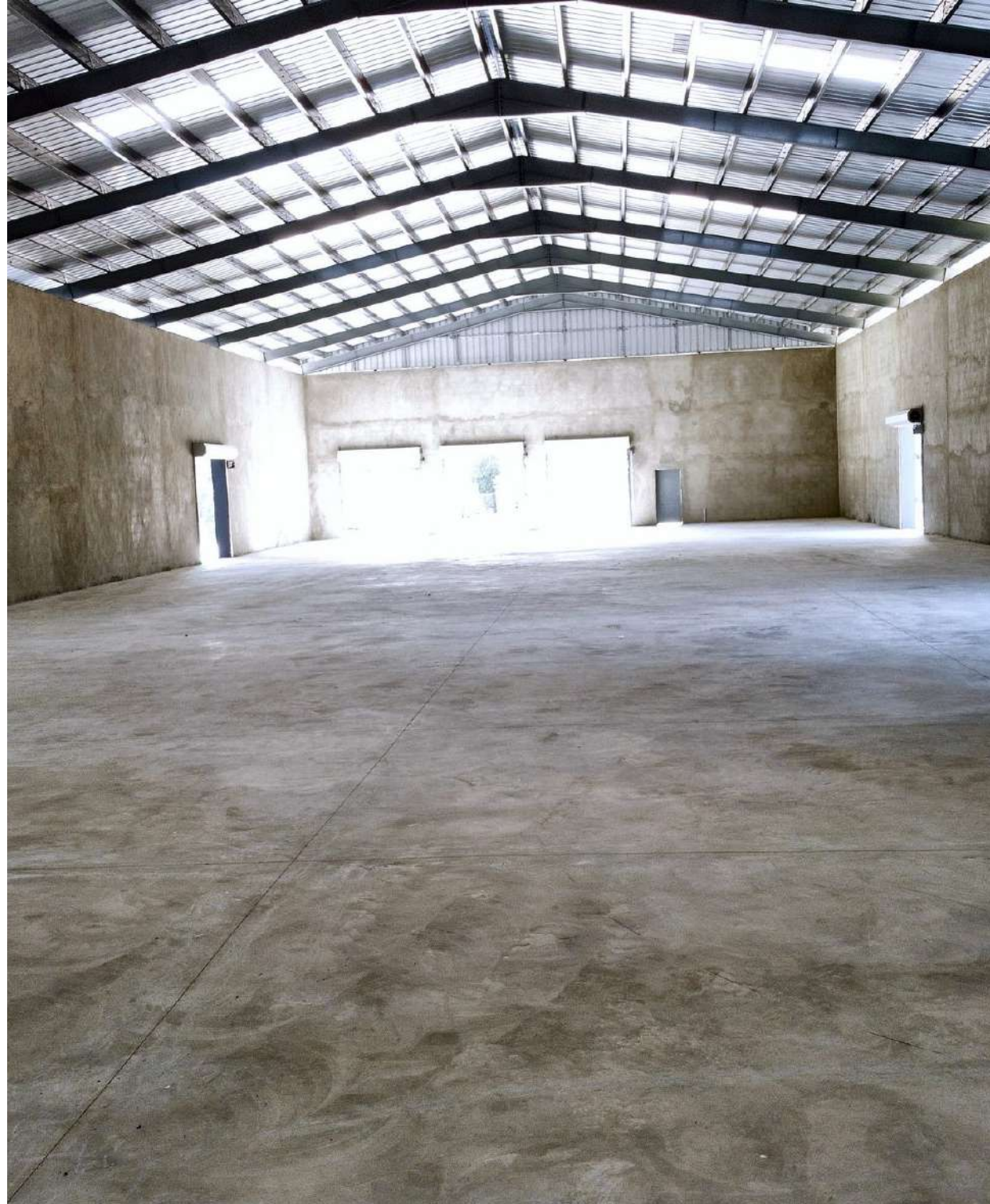
Doble altura: 6 m de altura libre bajo la armadura metálica de cubierta.
