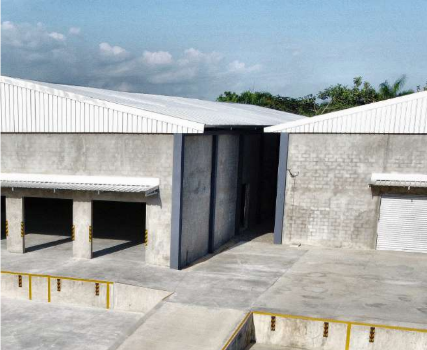
Plataforma de muelles en concreto y rampa compartida entre las Naves 2 y 3.
