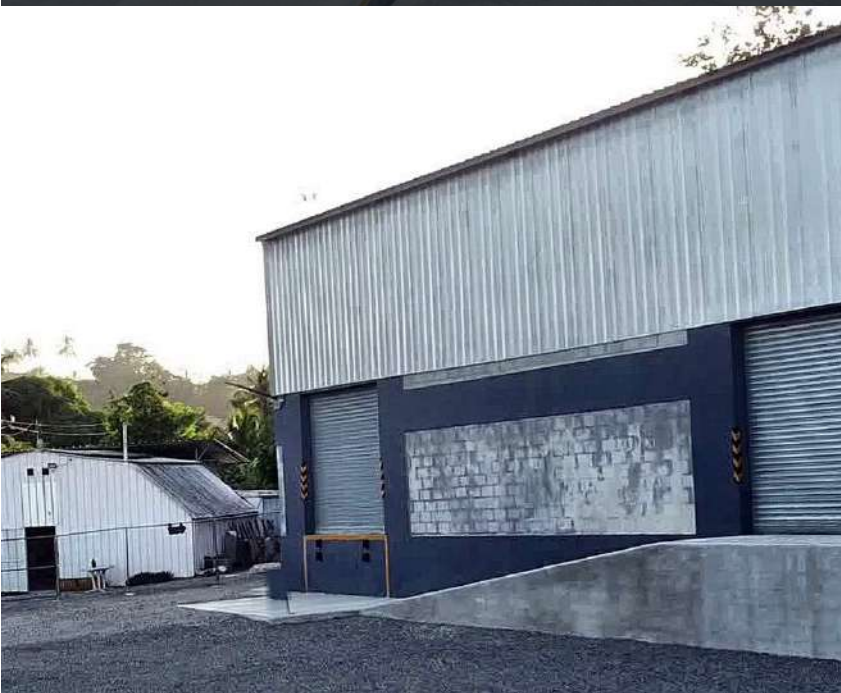
Patio de maniobras en gravilla compactada y andén en concreto.
