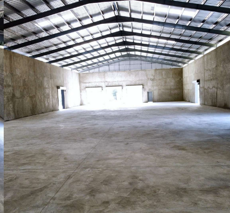
Armadura metálica y cubierta de acero galvanizado.
