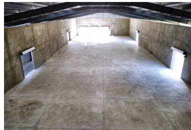
Piso de concreto industrial.
