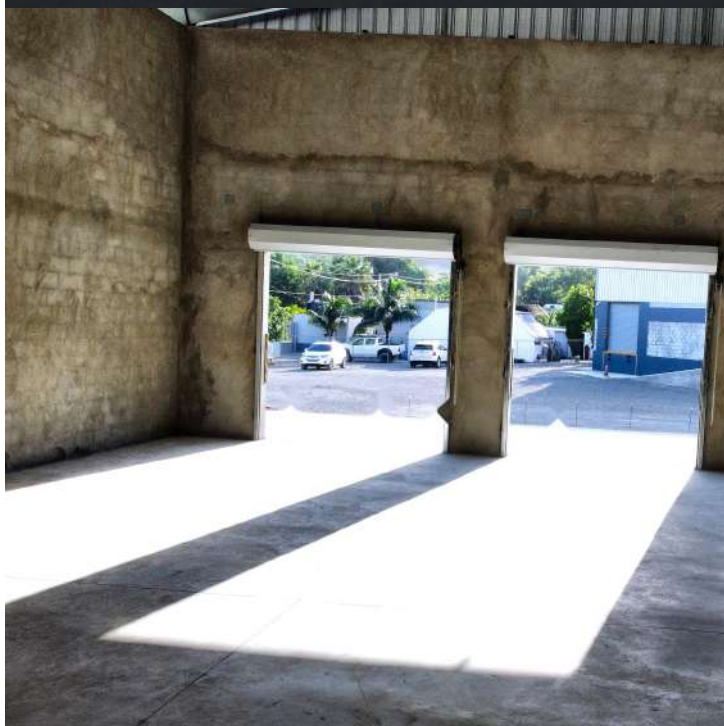
Interior hacia los portones de muelle.
