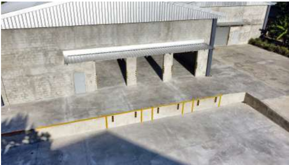
Rampa de carga compartida con la Nave 2, junto a los muelles.
