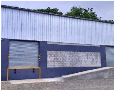
Muelle con topes y rampa paralela a la fachada.
