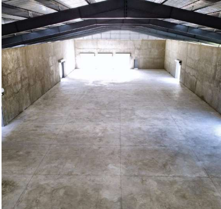
20 m de ancho libre, sin columnas intermedias a la vista.
