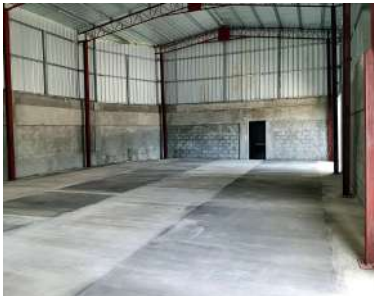
Interior: piso de concreto industrial y columnas metálicas.
