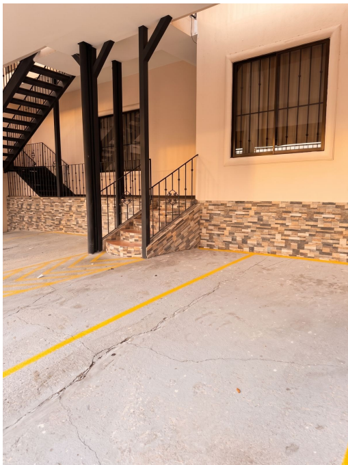
Área de parqueo y escaleras de acceso
