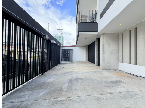
Acceso vehicular y parqueo
