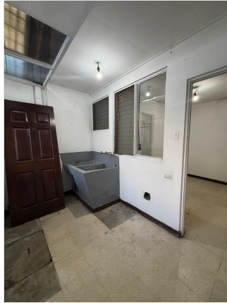
Cuarto de pilas
