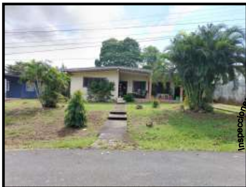
VISTA GENERAL DE LA PROPIEDAD
