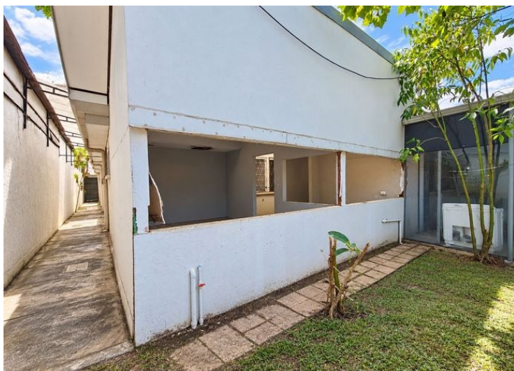
Patio y corredor lateral
