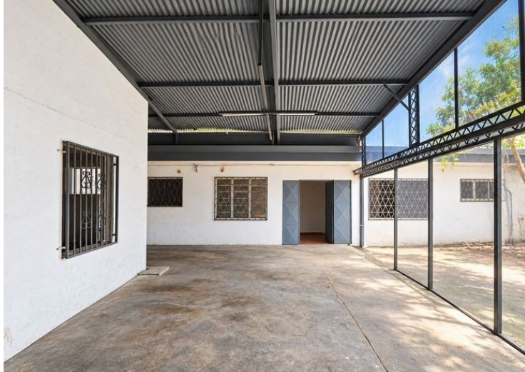
Cochera amplia y techada
