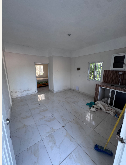
Interior de la segunda unidad
