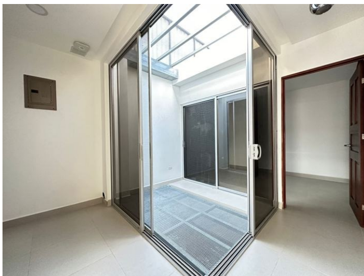
Tragaluz con ventilación natural
