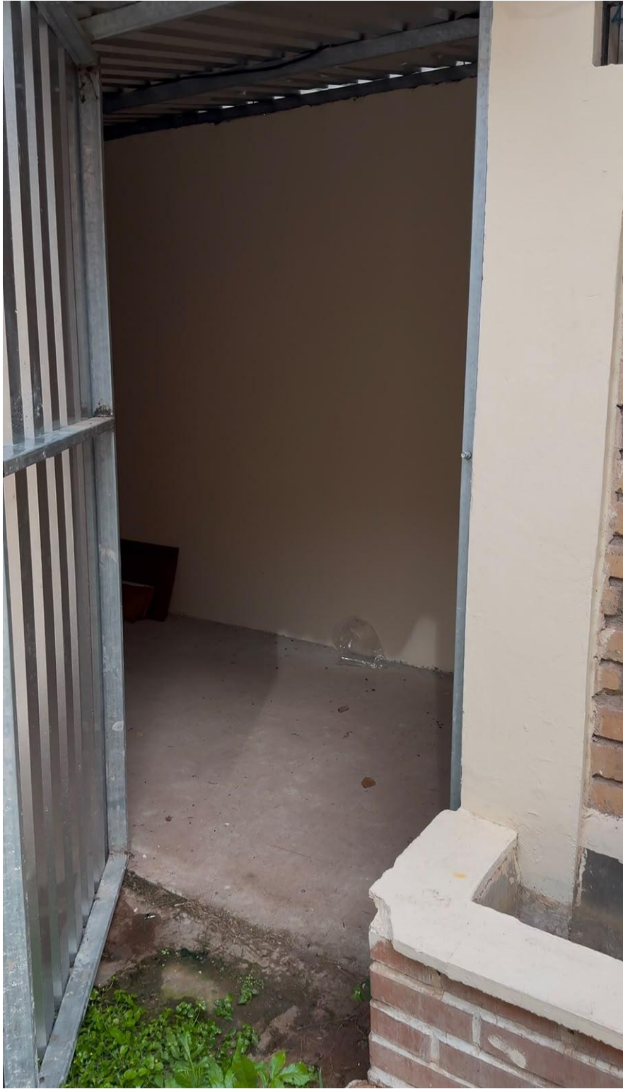
Entrada a Bodega
