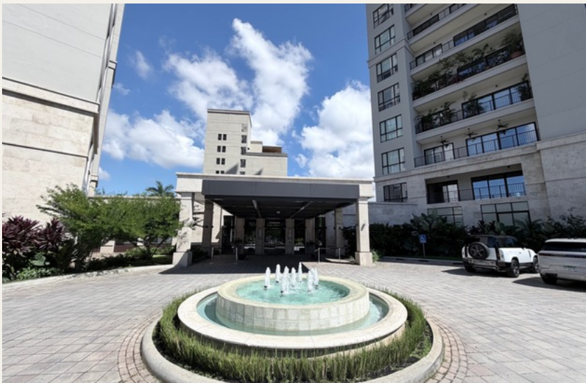
Acceso y fachada
