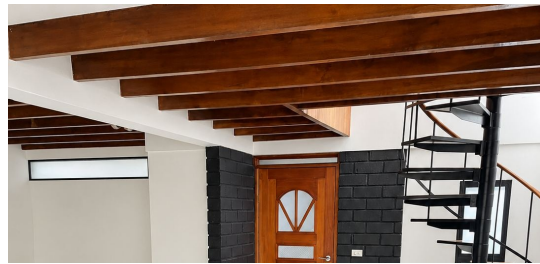
Planta baja con vigas de madera
