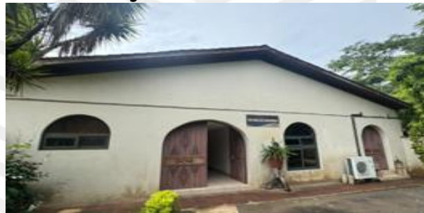
Oficinas existentes dentro del terreno
