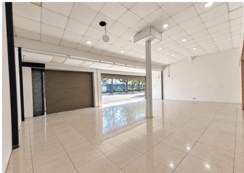
Salón iluminado con cielo suspendido
