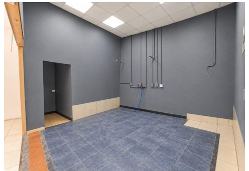
Cuarto con instalación eléctrica y de agua
